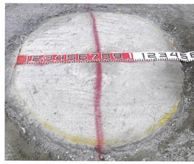
改良体杭頭部径確認(φ 1400)
