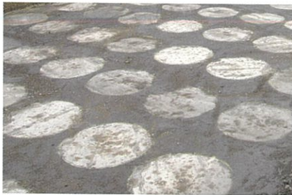
杭頭部確認状況
